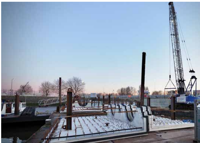
Op maat gemaakte waterdichte afsluiting van havenkademuur
