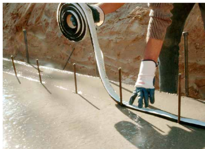
Verwerking in verse beton
