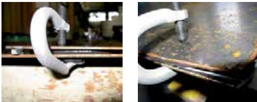
Aanbrengen van de TRiGOFORM® klembeugel aan weerszijden van de overlapping
