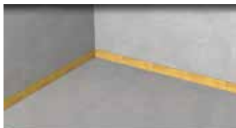
Randisolatie aanbrengen
