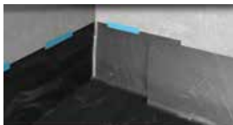
PE-afdichtfolie aanbrengen
