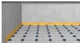
Rubber blokken aanbrengen
