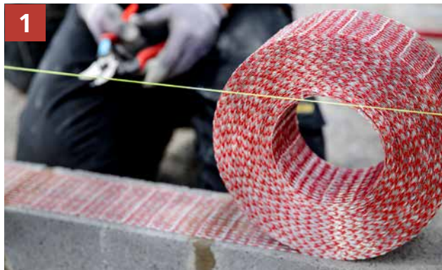
1 Plaats Murfor® Compact koud op de stenen
