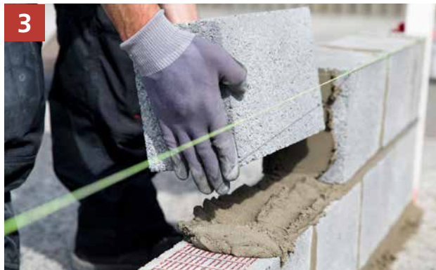
3 Plaats de volgende steenlaag
