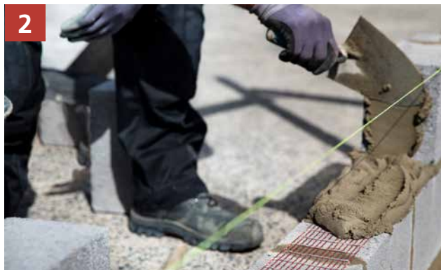
2 Breng daarna een laag mortel aan
