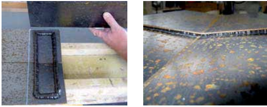
Aanbrengen van de TRiGODicht kleefpasta Hierbij een rildikte van 10 mm aanhouden Voegblik plaatsen, 100 mm overlappend
