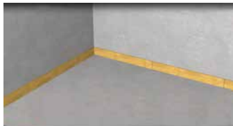
Randisolatie aanbrengen
