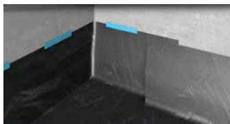
PE-afdichtfolie aanbrengen
