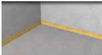
Randisolatie aanbrengen
