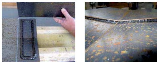
Aanbrengen van de TRiGOdicht kleefpasta Hierbij een rildikte van 10 mm aanhouden Voegblik plaatsen, 100 mm overlappend
