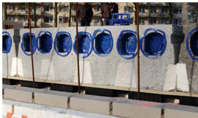
Akoestische ont koppeling van een geïsoleerde kanaalplaatvloer d.m.v. Mavo-dBreak Isostruct
